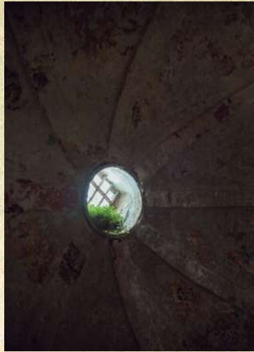
Lucernario in cima alla cupola dello stabilimento
